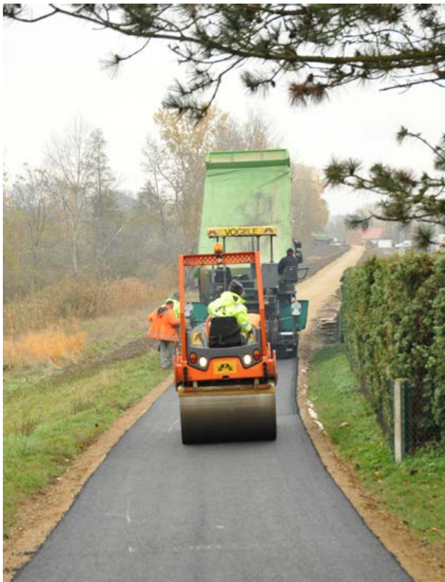
Asfaltování cyklostezek na hrázích.
