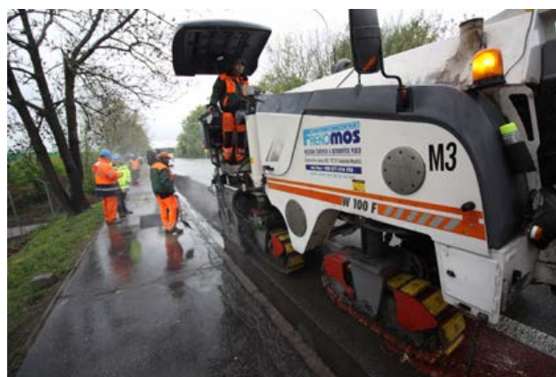
Oprava mostu u Penny Marketu.
