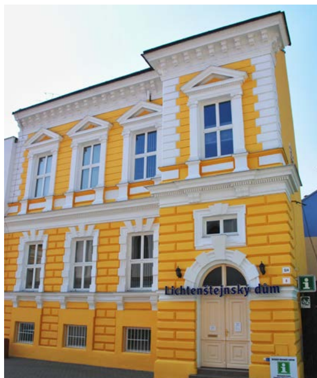
TIC Břeclav sídlí v Lichtenštejnském domě.
