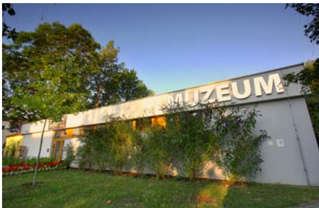
Budova MMG pod vodárnou.
